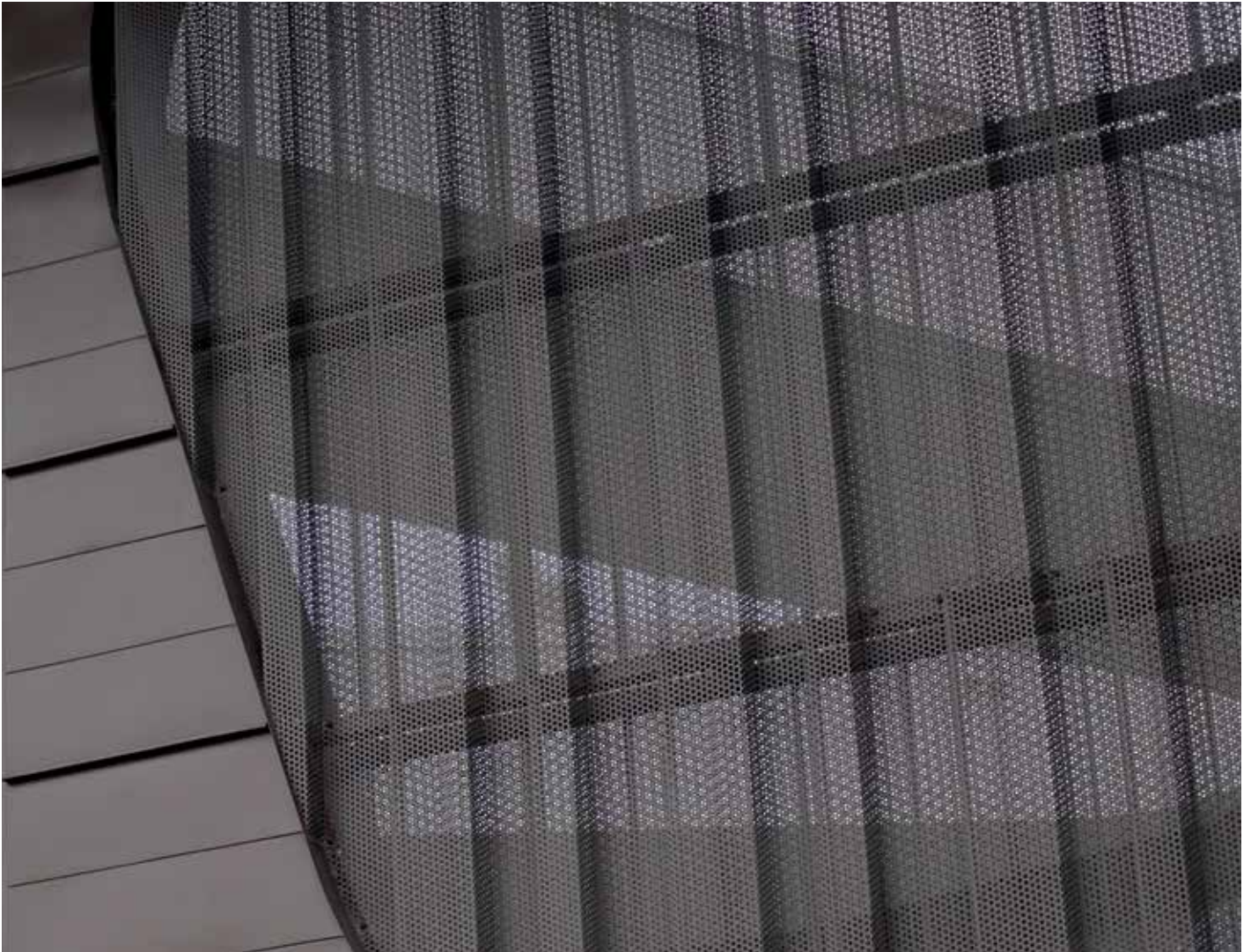
Pipia House, Tbilisi – Georgië Profiel 6
